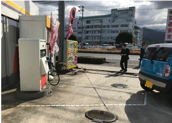
図12 固定注油設備前の作業スペース
