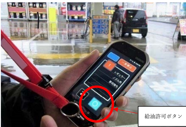
図2 可搬式の制御機器の様子 (給油許可前)
